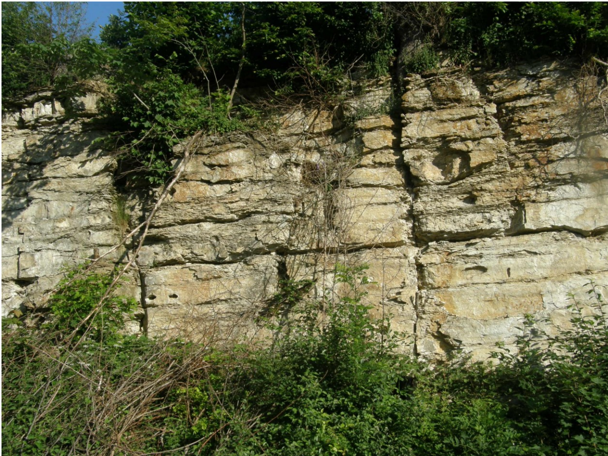
Obr.č. 5 : Kolektor B na Žamberecku, rajon 426, při silnici na Pastvinskou přehradu
